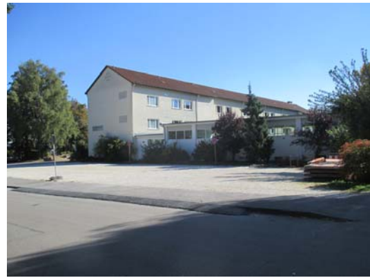
Abbildung 28: Freifläche Fischerweg – ehem. Kino Quelle: WHS 2015
