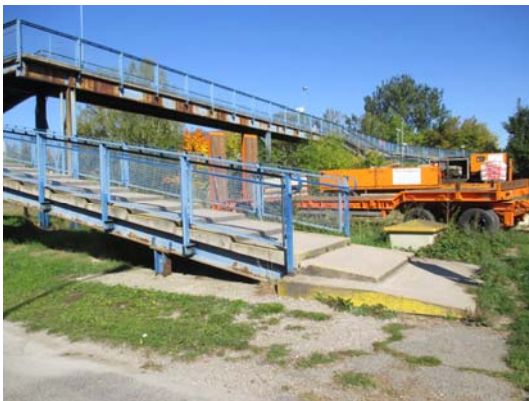
Abbildung 34: Fußgängerüberführung Quelle: WHS 2015
