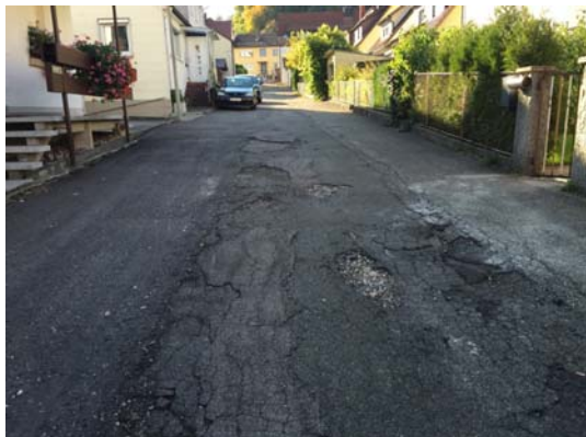
Abbildung 38: Parken im Straßenraum Quelle: WHS 2015
