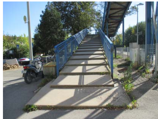
Abbildung 35: Fußgängerüberführung Quelle: WHS 2015
