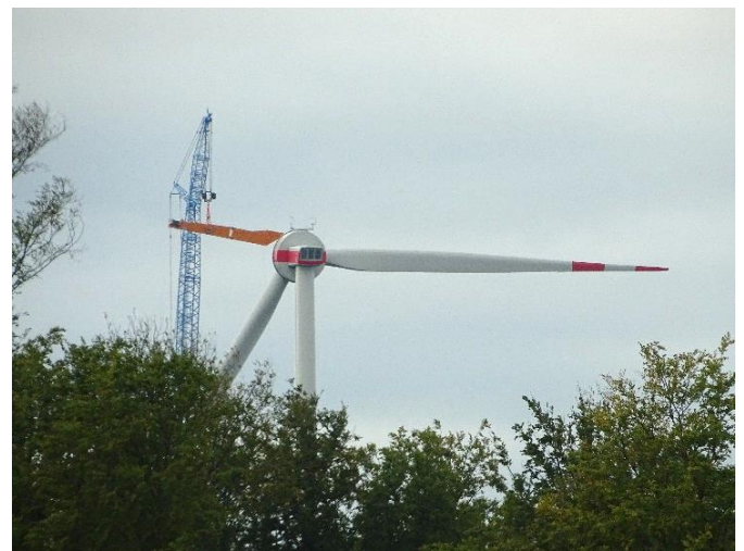
Windpark Nattheim – Montage der Rotorblätter bei den Windkraftanlagen Kleinkuchen
